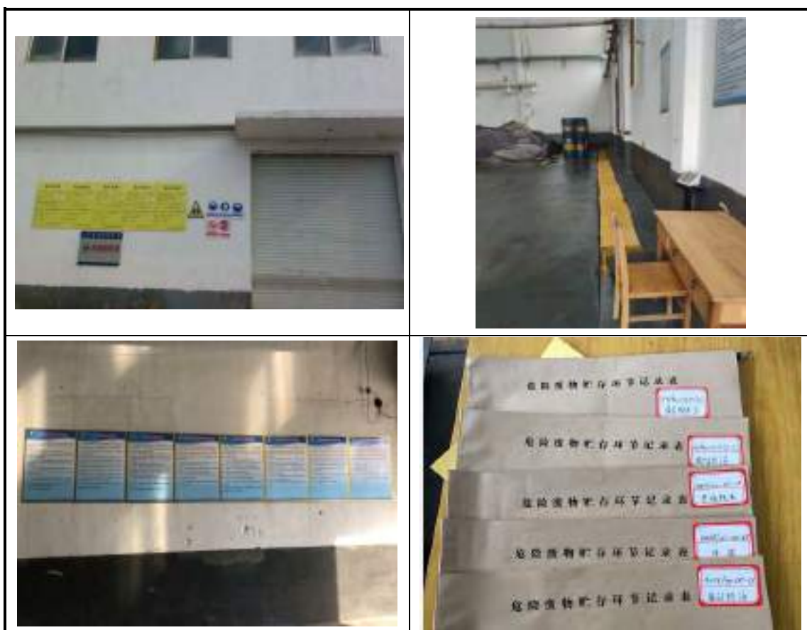
图6.2-38 现有危废暂存间建设实景图
